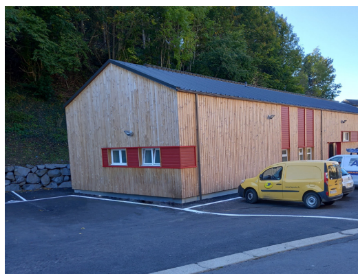
© Pascal Cohade, Equipement technique, Commune de Rochefort-Montagne 2021 - 215m 2 – 15 m 3 de BTMC™ Architecte : Pascal Cohade
